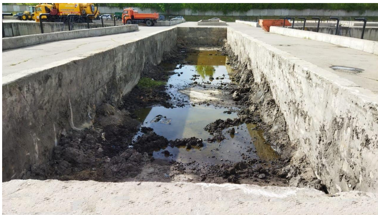
Рисунок 2. – Песко-иловая площадка, подготовленная для проведения апробации
