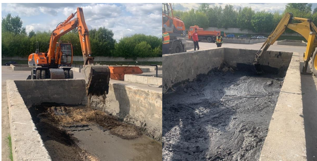
Рисунок 15. – Процесс перемешивания ингредиентов, необходимых для получения Отхода
