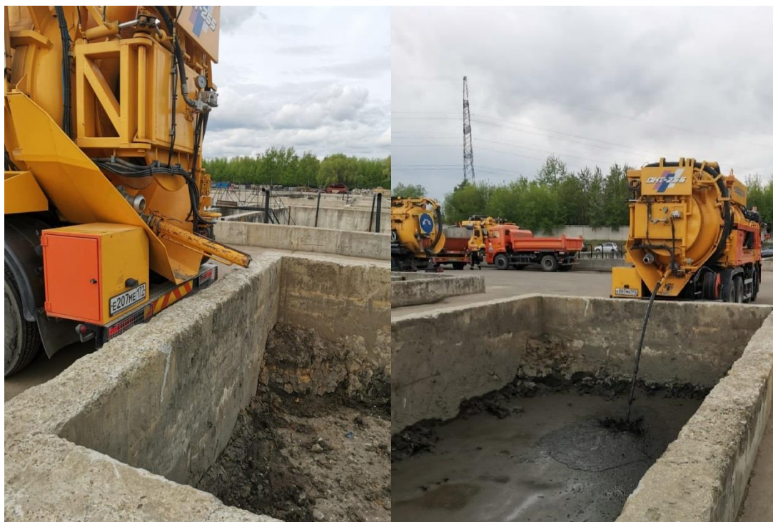
Рисунок 3. – Процесс слива обводненных отходов
